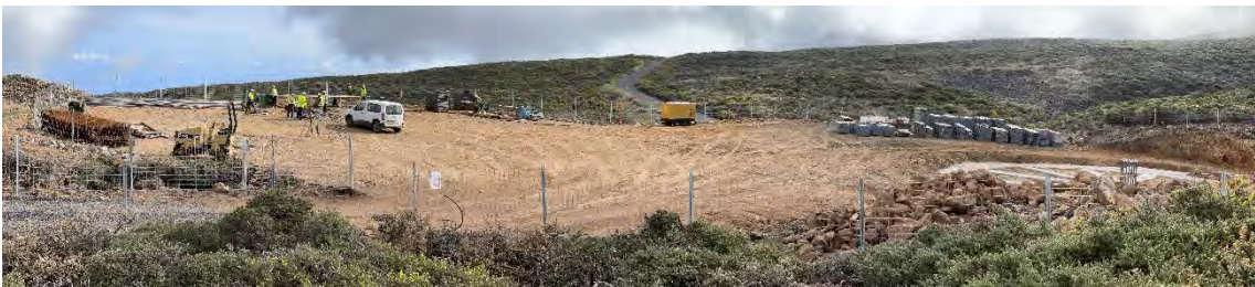
Panorámica LST4, se observa el trabajo en el taller de ferralla.
