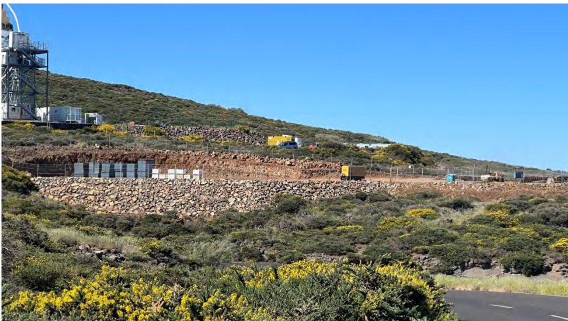
Escollera LST4, donde se aprecia el acopio de metales.
