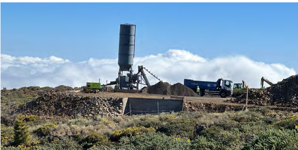
Vista plataforma auxiliar LST2 y muro de contención y protección zona de amontonamiento
