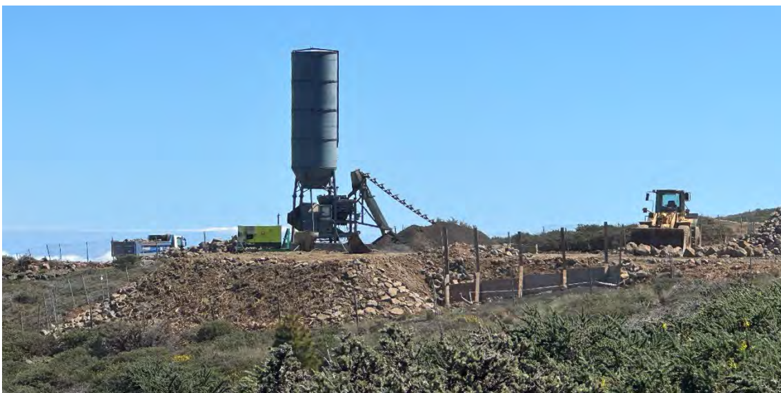
Vista zona de hormigonera y acopio de grava.
