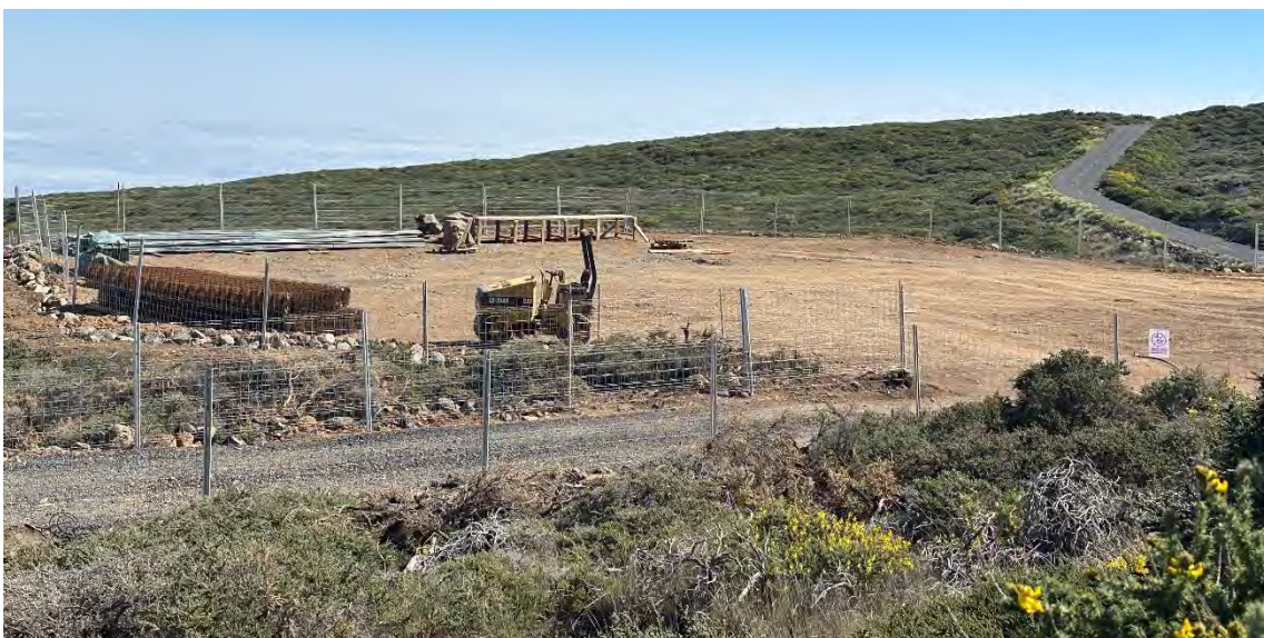
Zona de acopio de la ferralla
