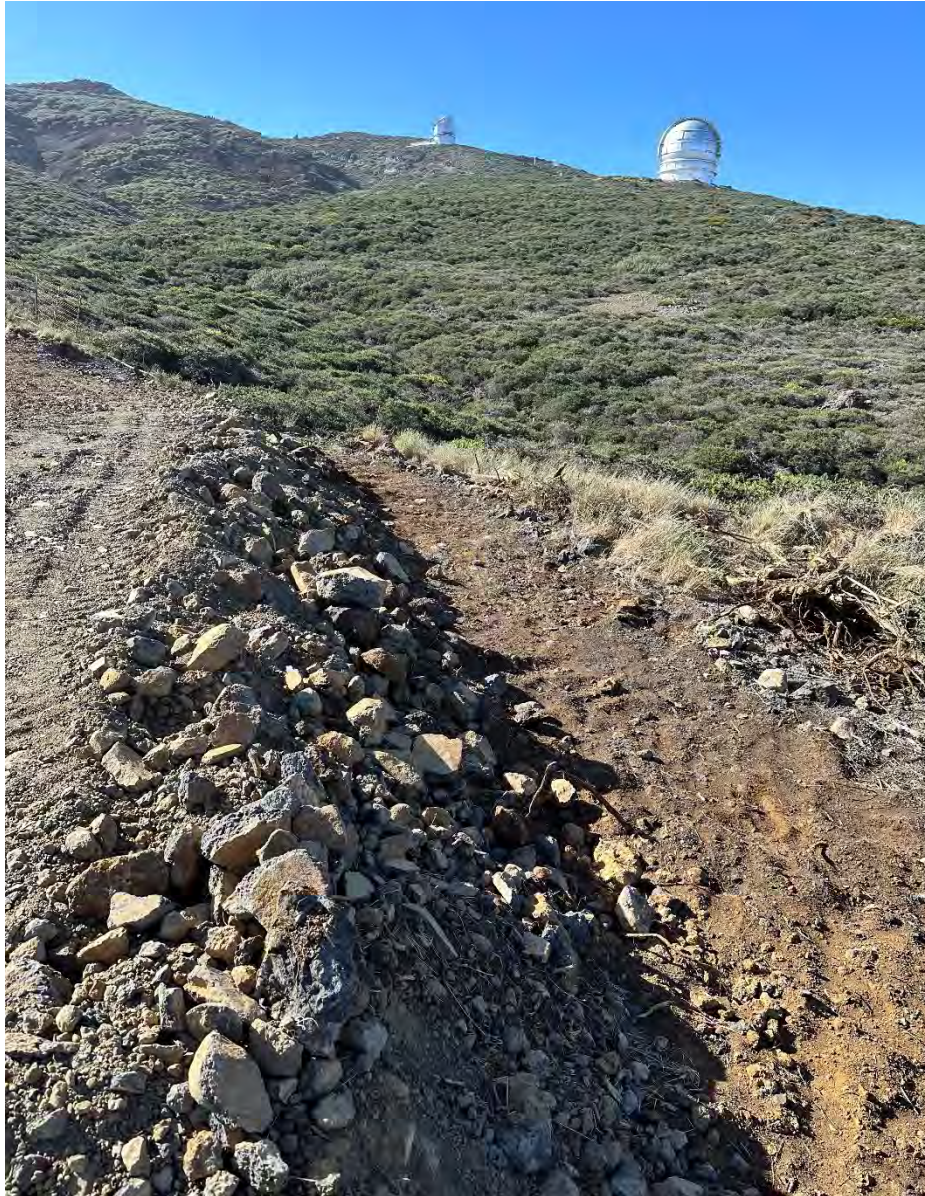
Se observa la separación entre el corredor ecológico y la zona de la pared de piedra que conformará la plataforma definitiva del LST2
