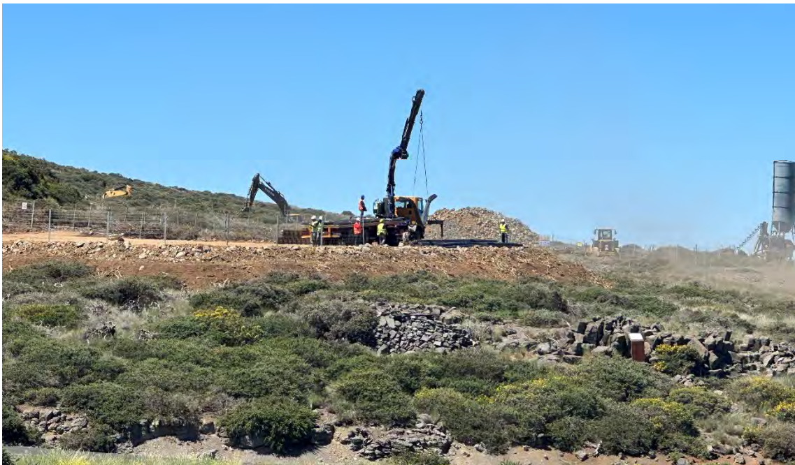
Descarga ferralla en el LST4
