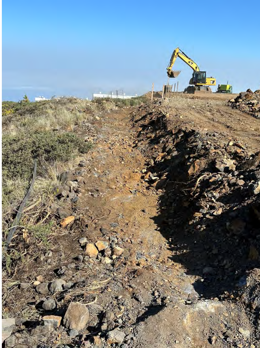
Comienzo separación plataforma definitiva LST2 y su separación con el corredor ecológico
