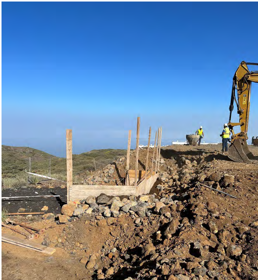
Comienzo hormigonado muro de contención y protección zona de importancia arqueológica.
