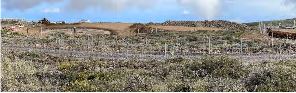
Panorámica LST3, donde se aprecia la plataforma auxiliar el acopio de pétreos ya extendidos y mayor elevación de la plataforma. Se observa el hormigón del sistema radial de la base del telescopio.
