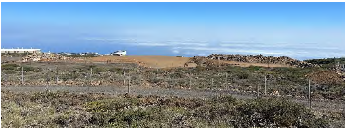
Panorámica LST3, donde se aprecia la plataforma auxiliar el acopio de pétreos para su extendido y reserva para su uso en las plataformas definitivas de los telescopios.
