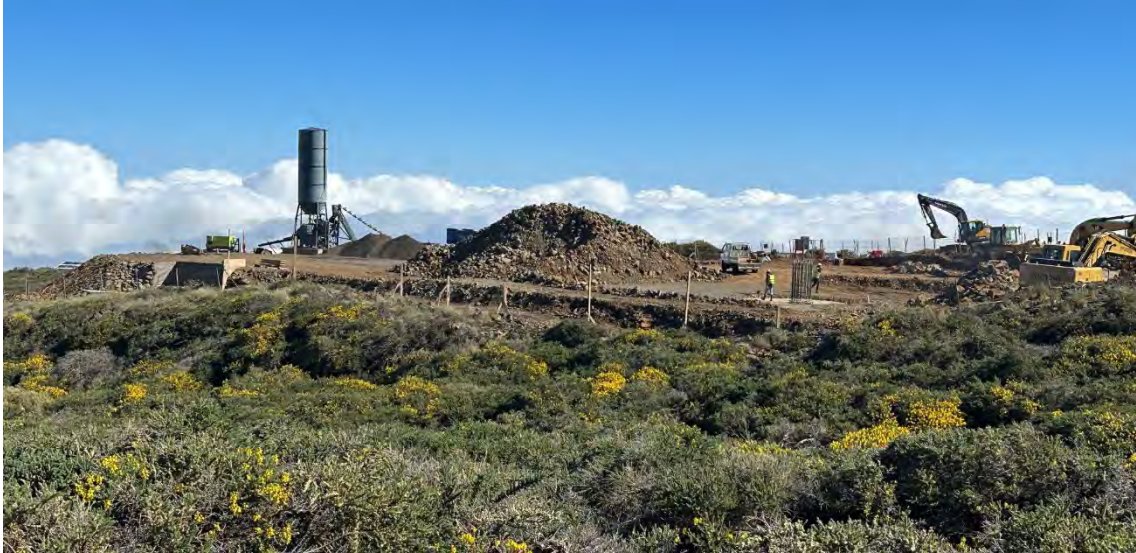
Plataforma LST2, donde se aprecia la colocación de los tablonés que servirán de soporte y nivelado para la conformación del muro de piedra de la plataforma definitiva del LST2.
