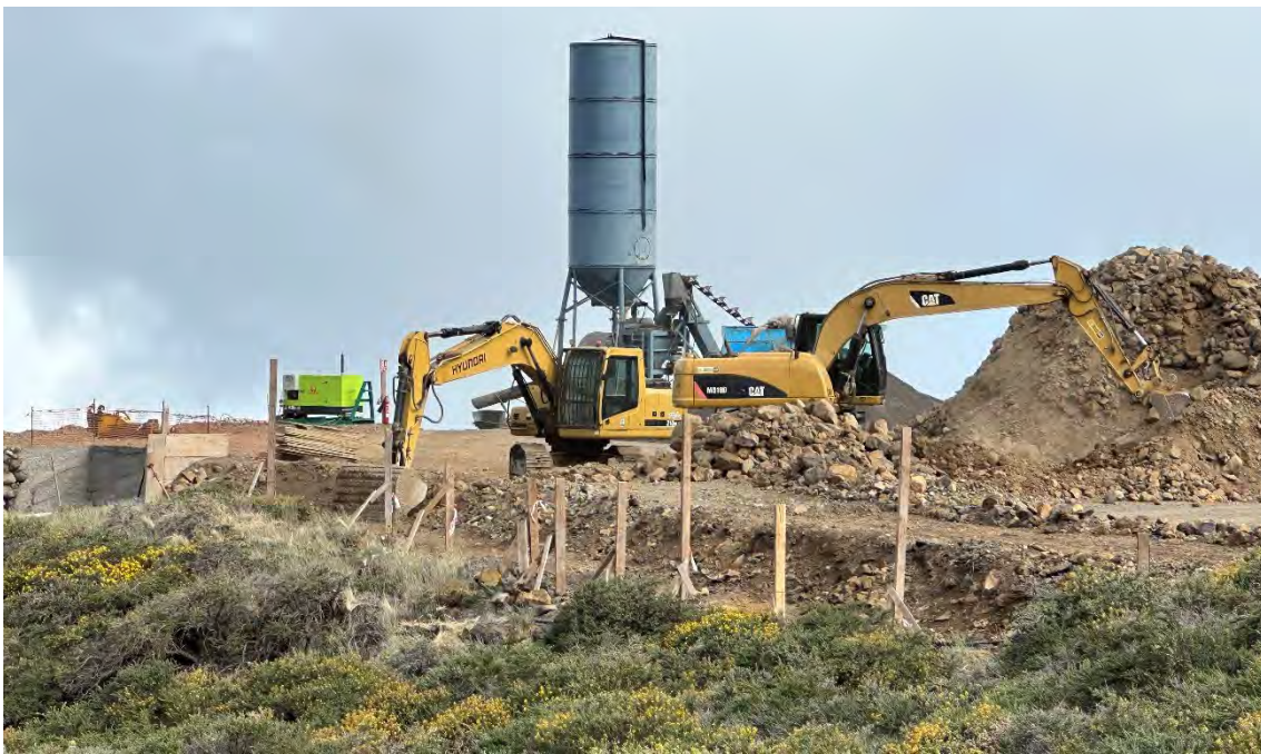
Plataforma LST2, donde se aprecia la colocación de los tablonés que servirán de soporte y nivelado para la conformación del muro de piedra de la plataforma definitiva del LST2.
