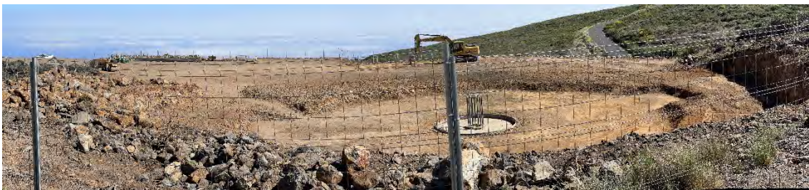
Plataforma definitiva LST4, se aprecia desmonte y formación de la base para la posterior colocación del hormigón radial que conforme la primera parte de la base del LST4
