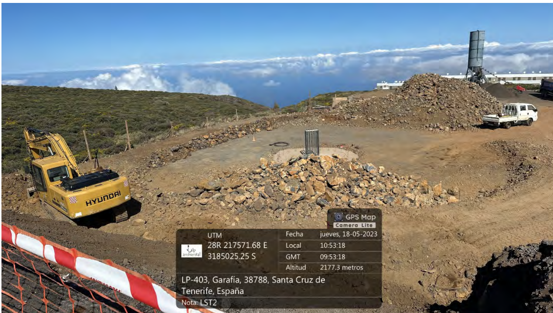
Comienzo desmonte plataforma helipuerto para la vía de acceso exterior del LST2
