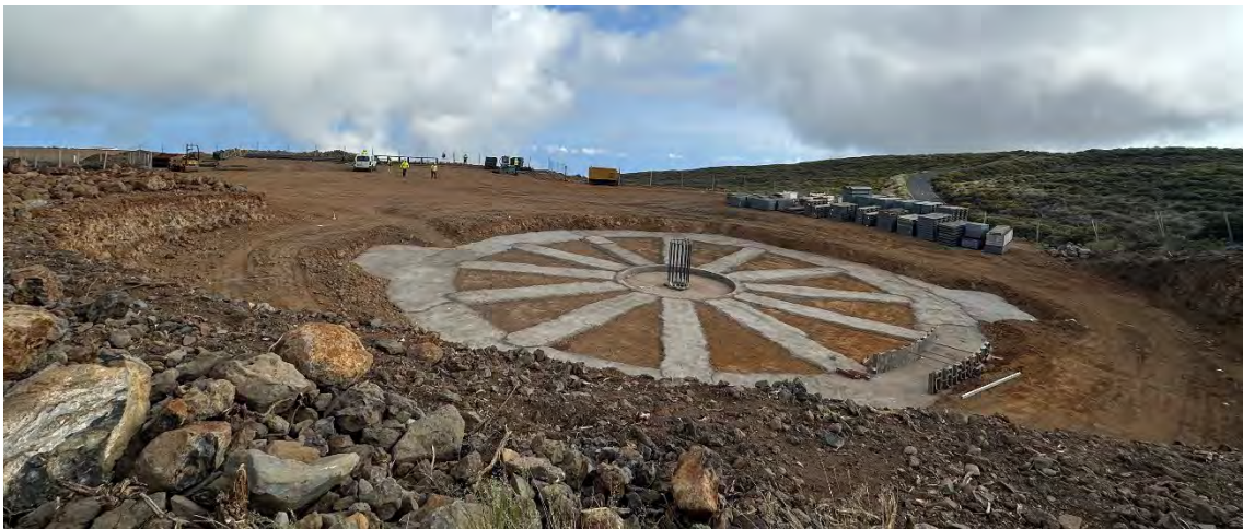
Plataformas del LST4 donde se aprecia el hormigonado del sistema radial. Se observa como se está comenzando a poner los moldes para el vertido del hormigón en el sistema radial de la base del telescopio.
