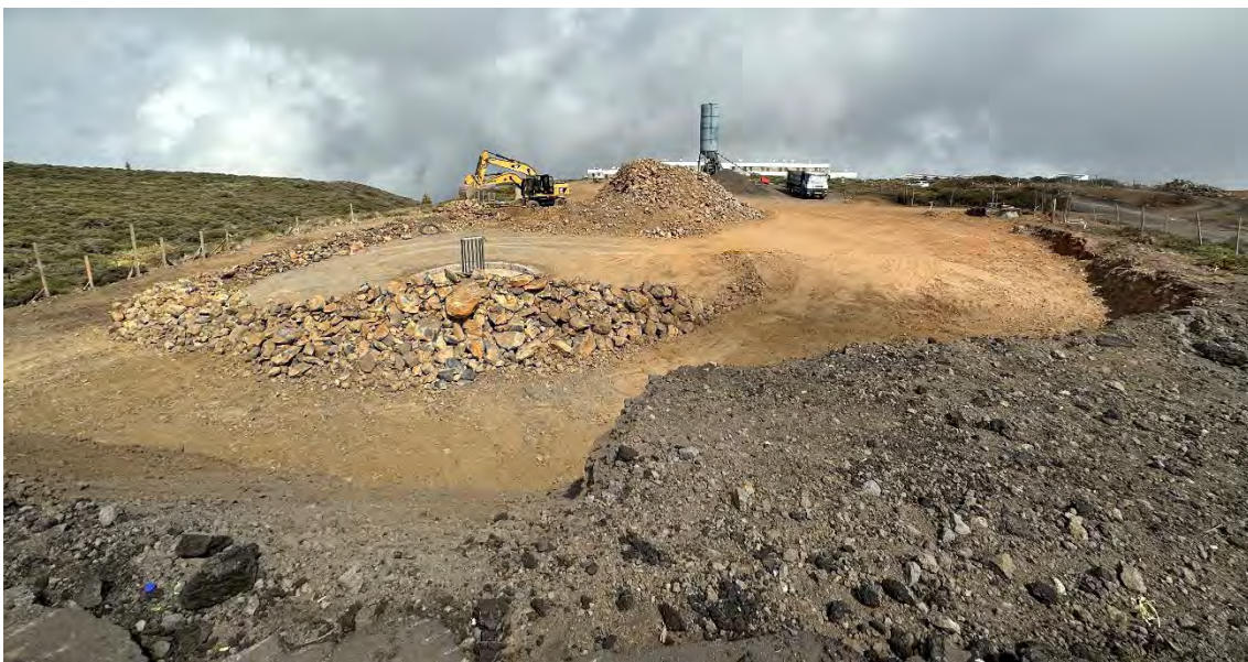
Desmante plataforma helipuerto para la vía de acceso exterior del LST2
