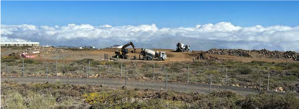
Panorámica LST3, donde se aprecia la plataforma auxiliar el acopio de pétreos ya extendidos y mayor elevación de la plataforma. Se observa como se esta realizando la colocación de hormigón en el núcleo central del telescopio.
