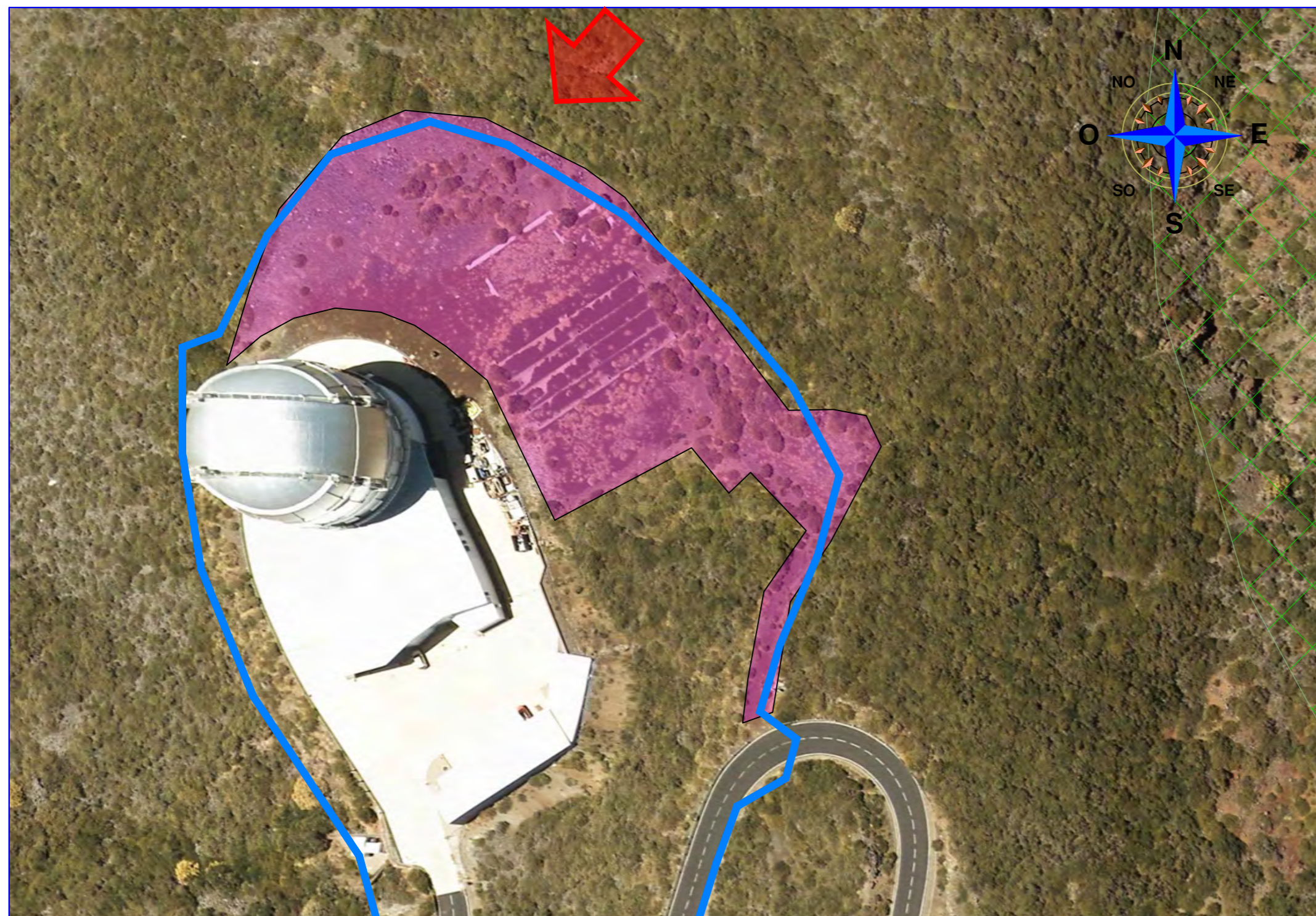
RECUPERACIÓN ÁREAS PERTURBADAS DURANTE CONSTRUCCIÓN DEL GRAN TECAN.
