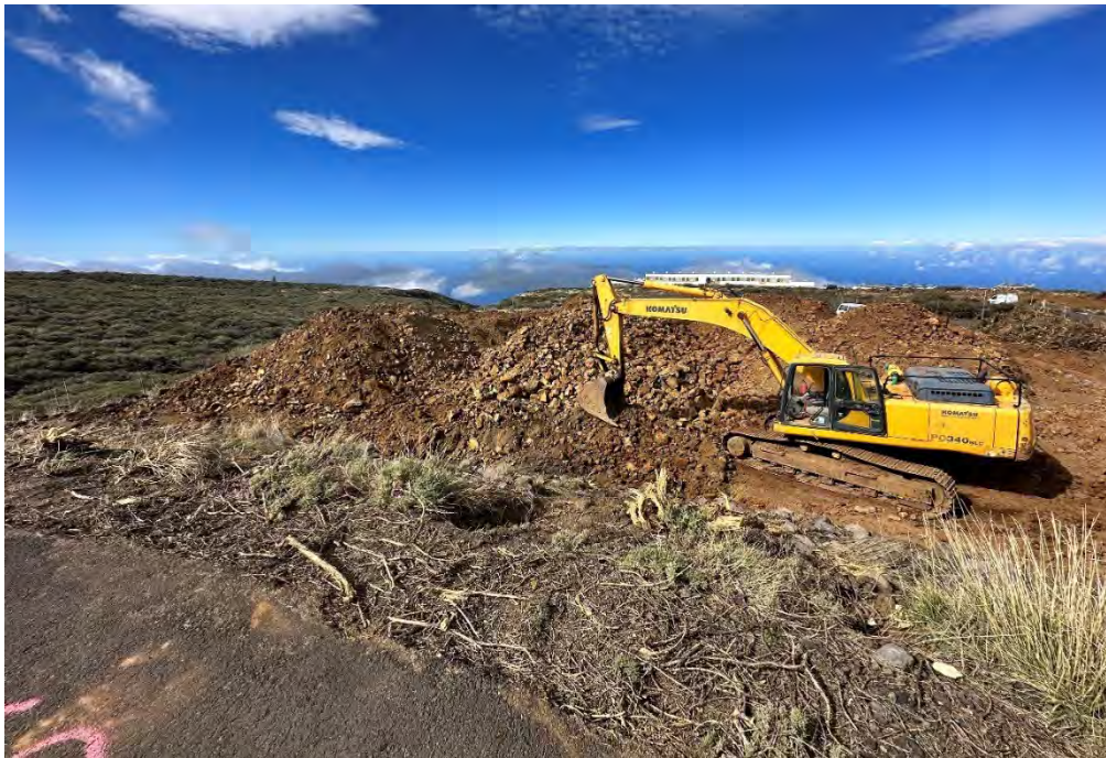
Maquinaria y movimiento de tierras en zona LST2
