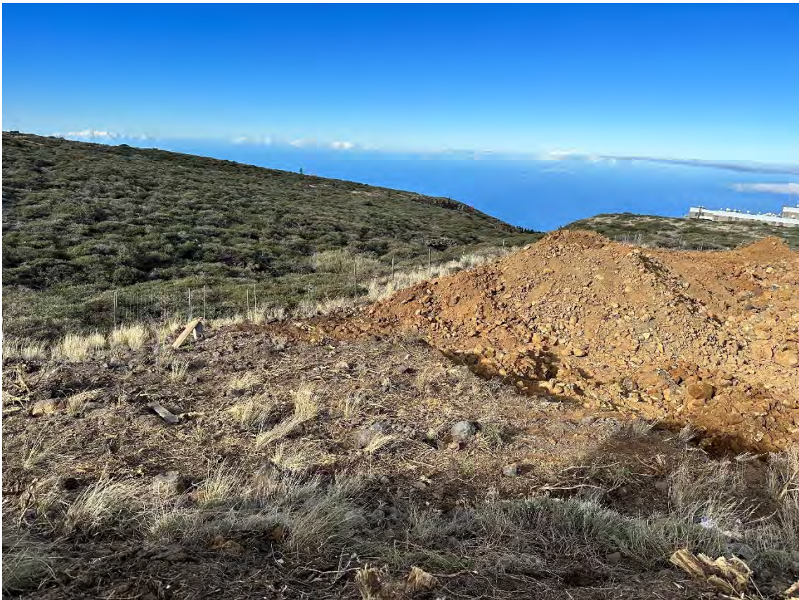
Comprobación vallada y la separación con el corredor ecológico en zona LST2
