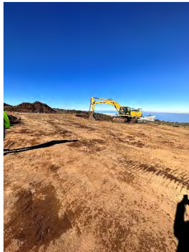
Maquinaria usada en el terraplenado de la zona de acopio de tierra vegetal bajo la futura plataforma auxiliar de montaje del LST3
