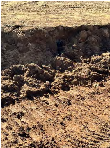
Extendido y aplanado de tierra vegetal
