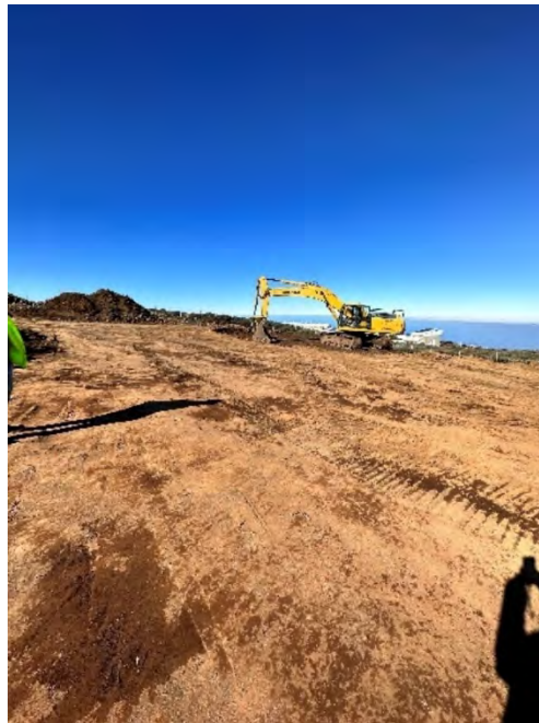
Compactación plataforma auxiliar LST3
