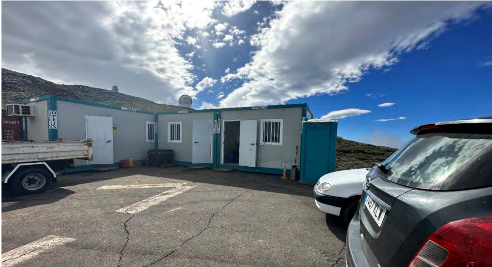
Imagen de la zona de trabajadores en el helipuerto próximo al LST2
