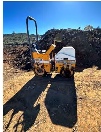
Maquinaria usada en el terraplenado de la zona de acopio de tierra vegetal bajo la futura plataforma auxiliar de montaje del LST3
