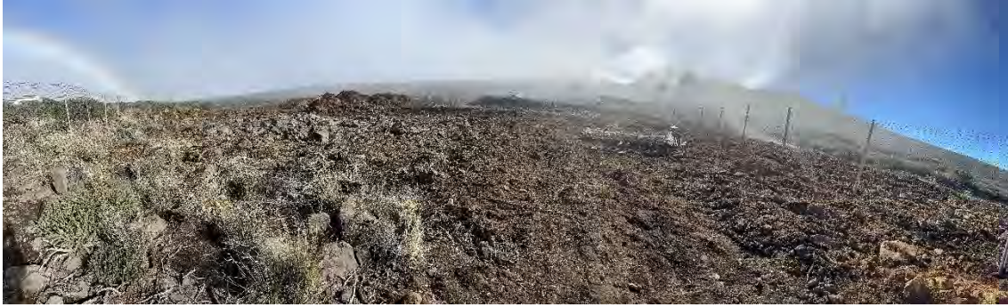
Zona LST3 donde se aprecia el vallado y su colocación, además del comienzo del movimiento de tierras, con la retirada de la capa superficial para el terraplenado
