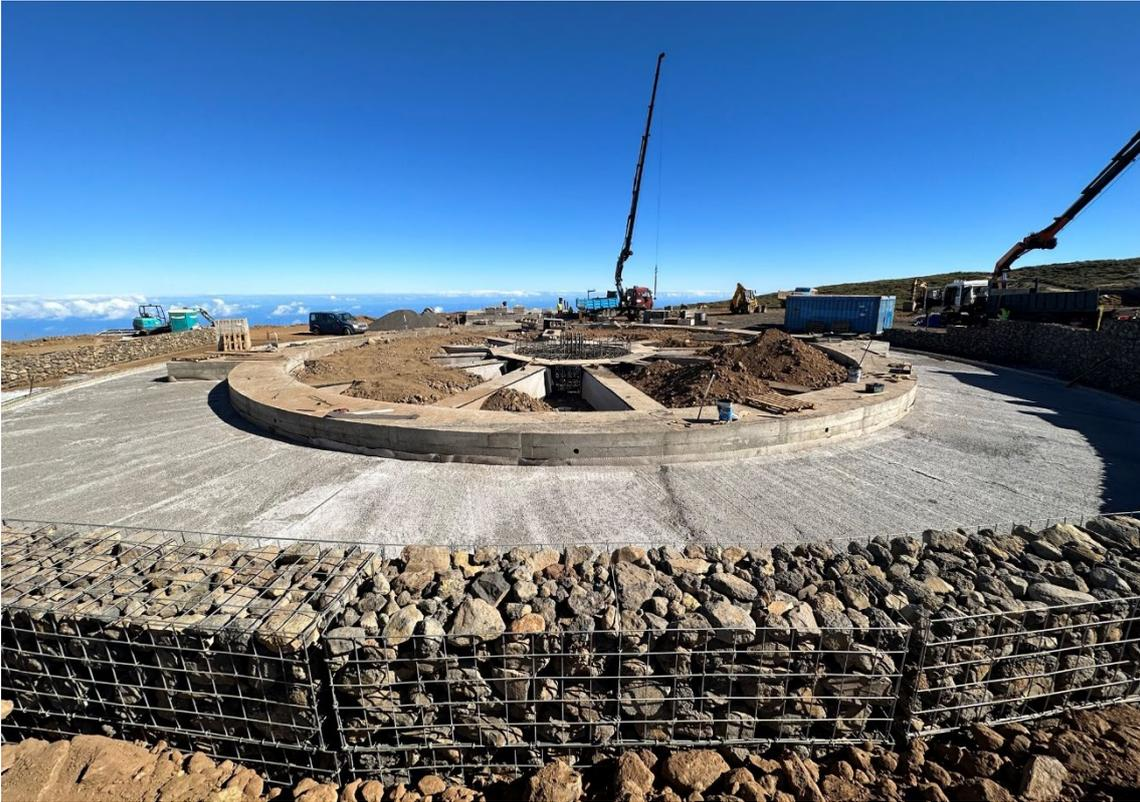
En la plataforma auxiliar, se ha retirado el acopio de material pétreo y se ha nivelado, procediendo al comienzo de la colocación de la piedra de machaqueo, evitando así el levantamiento de polvo y partículas que puedan afectar a las plantas o seres vivos de la zona.
