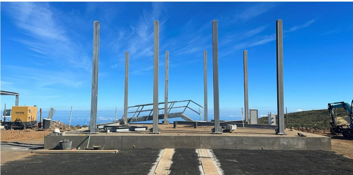
En lo que respecta a la plataforma definitiva del telescopio, se encuentra totalmente terminada, con la losa superior del sistema radial finalizado, al igual que los adoquines colocados en el acceso interior alrededor de la base del telescopio. Por lo que se considera, que este telescopio ya está casi terminado.
