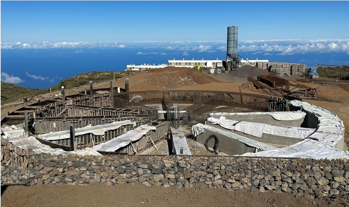
4. Inspección de la zona del LST3. Ya concluido desde la visita anterior el hormigonado de todo el sistema radial de la base del futuro telescopio, se ha continuado con la formación y colocación de hormigón en el acceso interior, justo alrededor del sistema radial, el cual posteriormente llevará adoquines, conformando correctamente este acceso o zona alrededor del telescopio.
