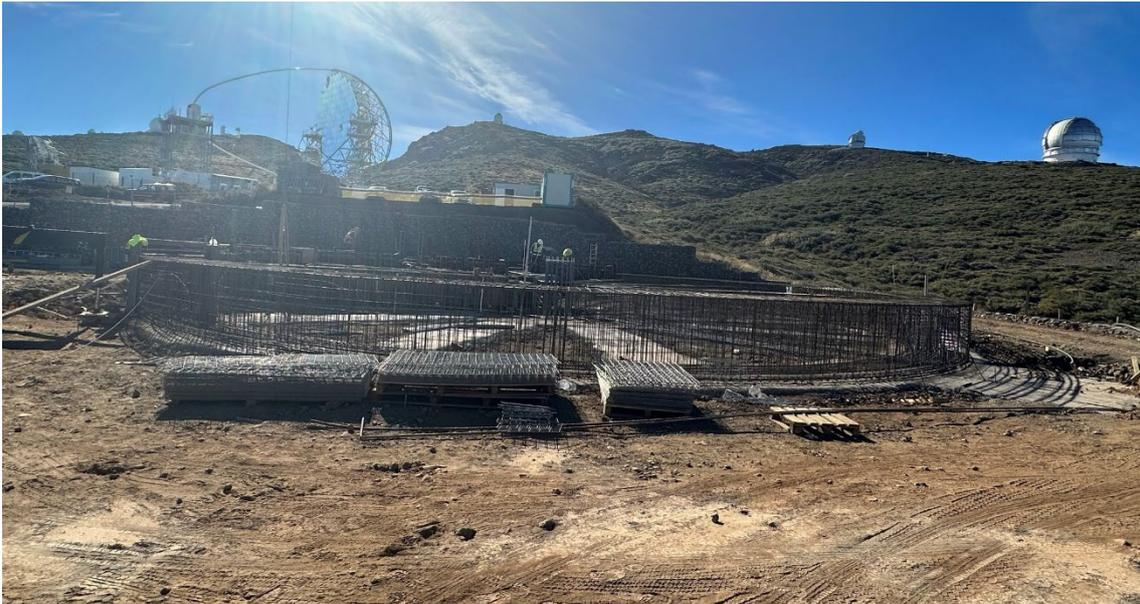
Formación de la armadura en espera de la base de la plataforma del LST2
