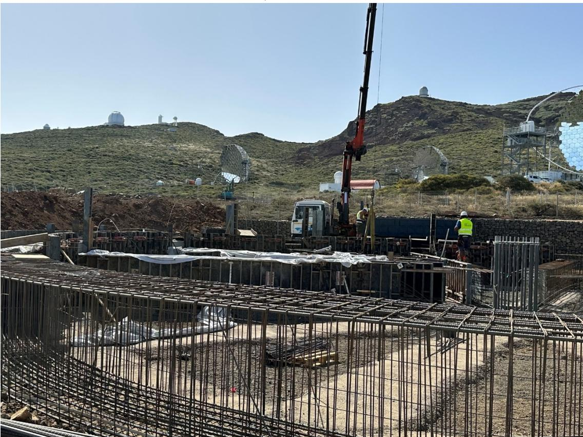
Detalle de la armadura en espera y encofrado del sistema radial del LST3.
