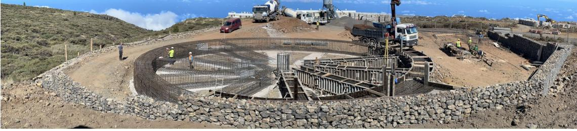
Se ha procedido al mayor desmante de la superficie del helipuerto superior, para crear el talud de amortiguación entre la zona del telescopio y el exterior que ya se encuentra casi conformado y con la pared de gaviones hasta su altura máxima.
