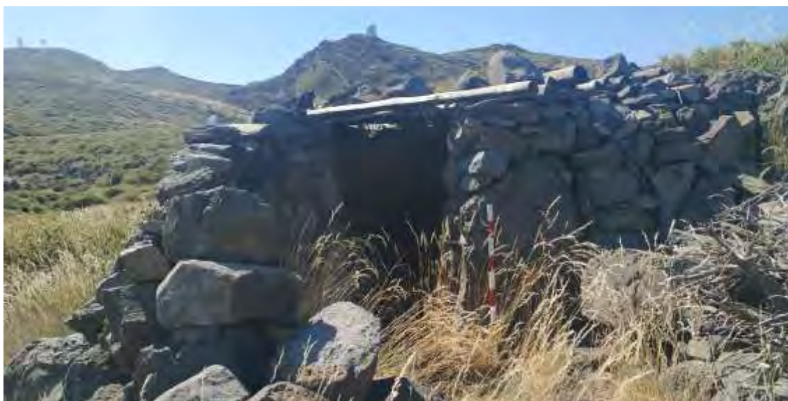
Entrada del abrigo pastoril donde se aprecia la techumbre de madera.
