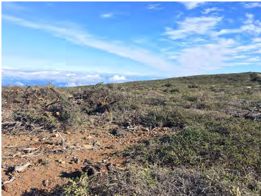
Balizamiento y desbroce
