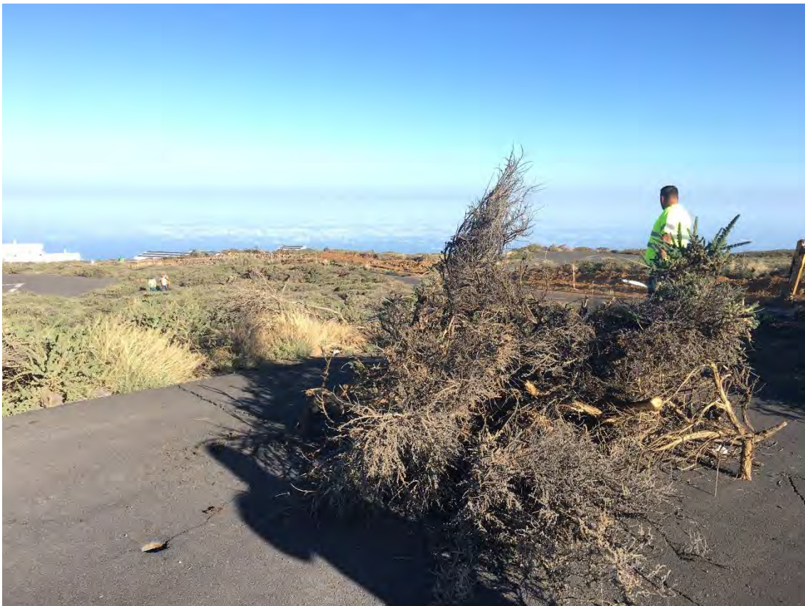
Comienzo de la retirada de material vegetal para la ULL
