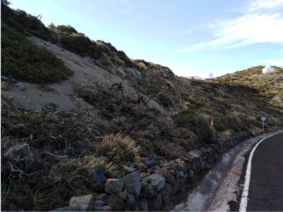
Figura 24. Talud de la carretera mostrando en su porción central la pobre colonización vegetal y un sustrato arenoso-pedregoso muy inestable.
