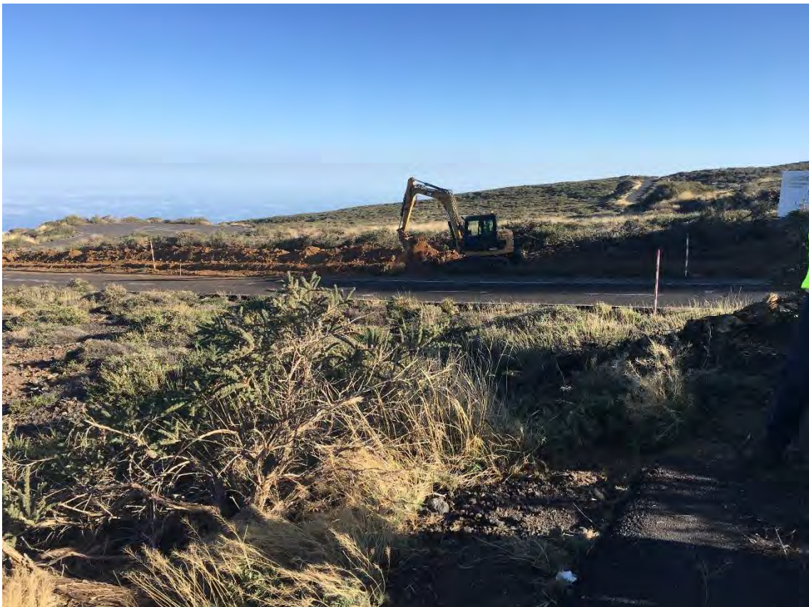
Maquinaria de la obra de canalización que se lleva a cabo simultánea a la ejecución de los LST
