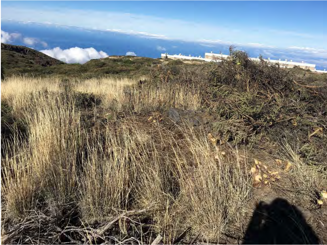
Comienzo del desbroce
