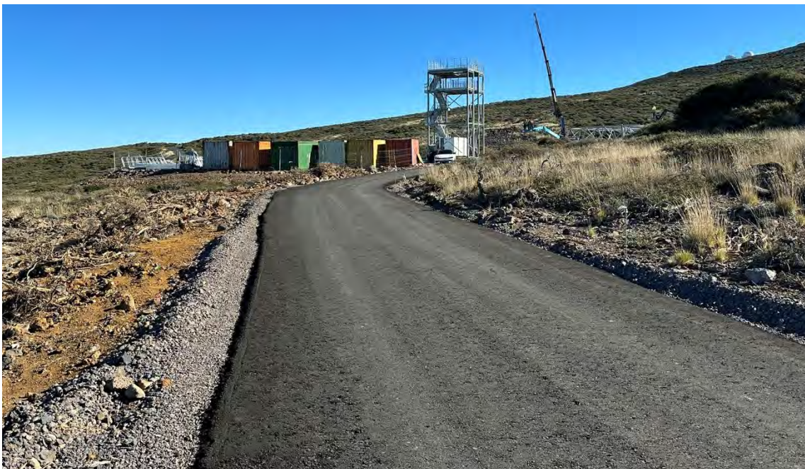
Acceso asfaltado hasta el LST4
