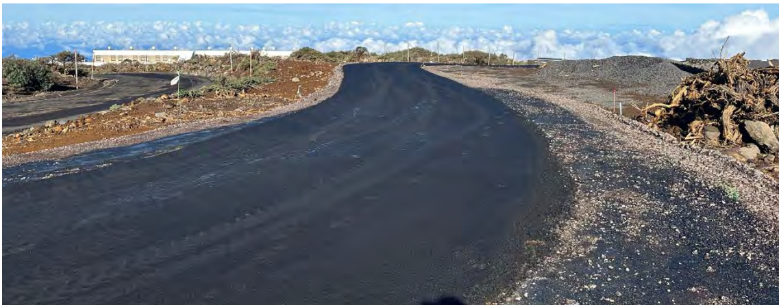
Acceso asfaltado hasta el LST3
