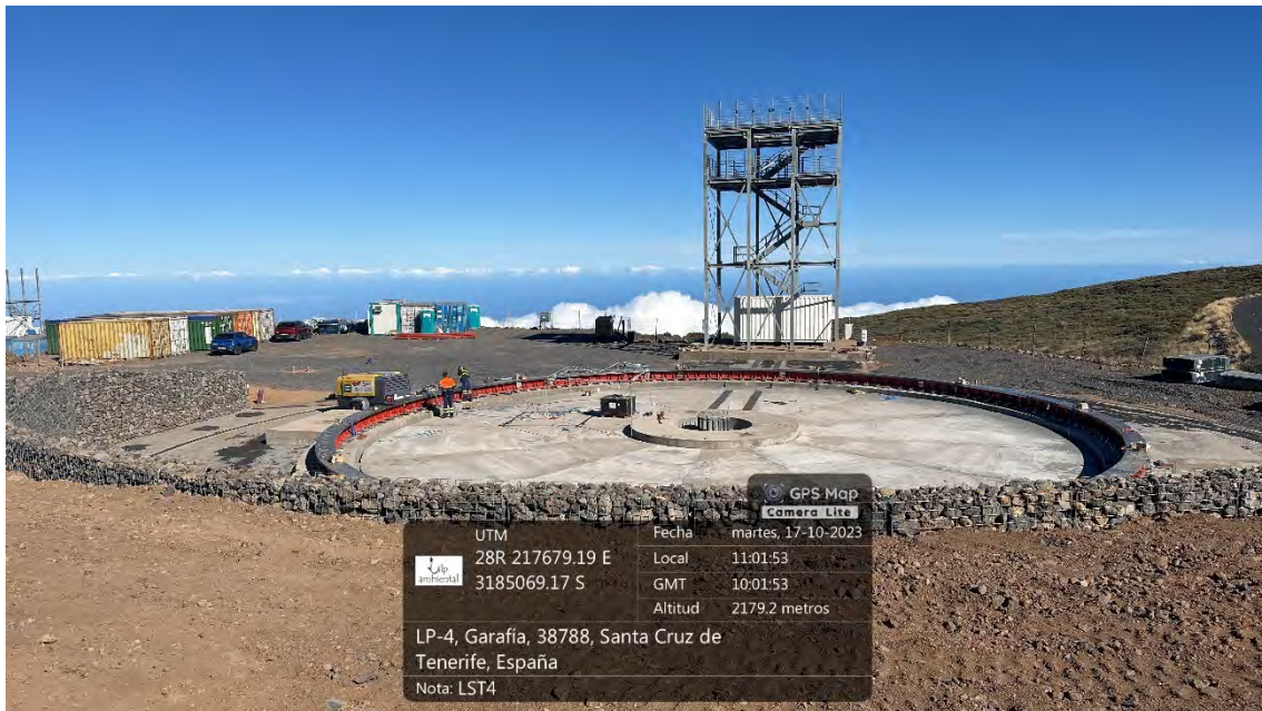
Vista general del LST4, se aprecia la colocación de piedra de machaqueo en la totalidad de la plataforma auxiliar y alrededor de la torre de descanso.
