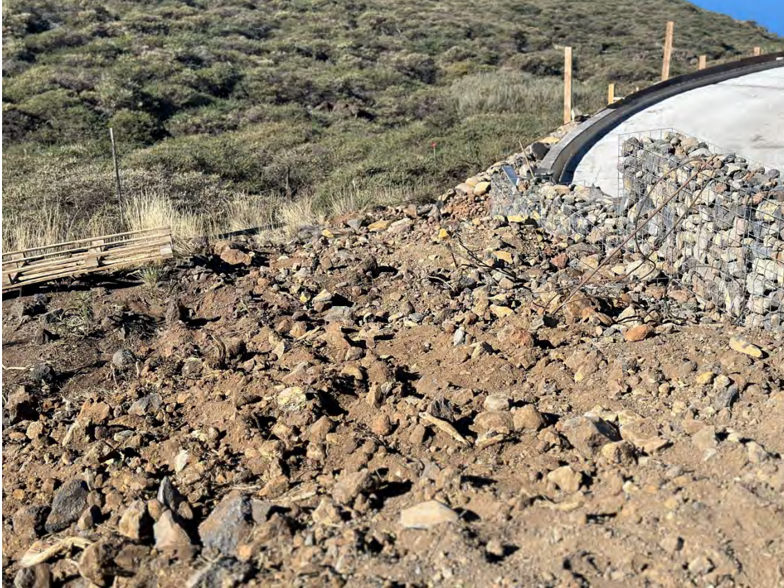
Plataforma desmonte helipuerto LST2
