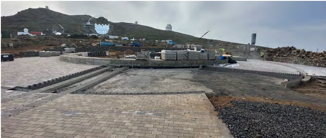
Plataforma de montaje del LST3, con la colocación del adoquinado
