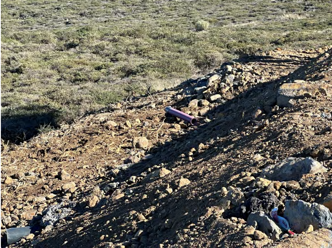
Zona talud LST3
