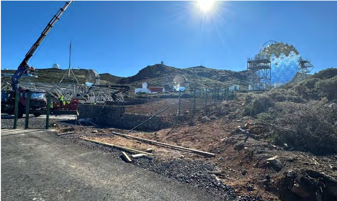
Colocación vallado y puerta y montaje del telescopio
