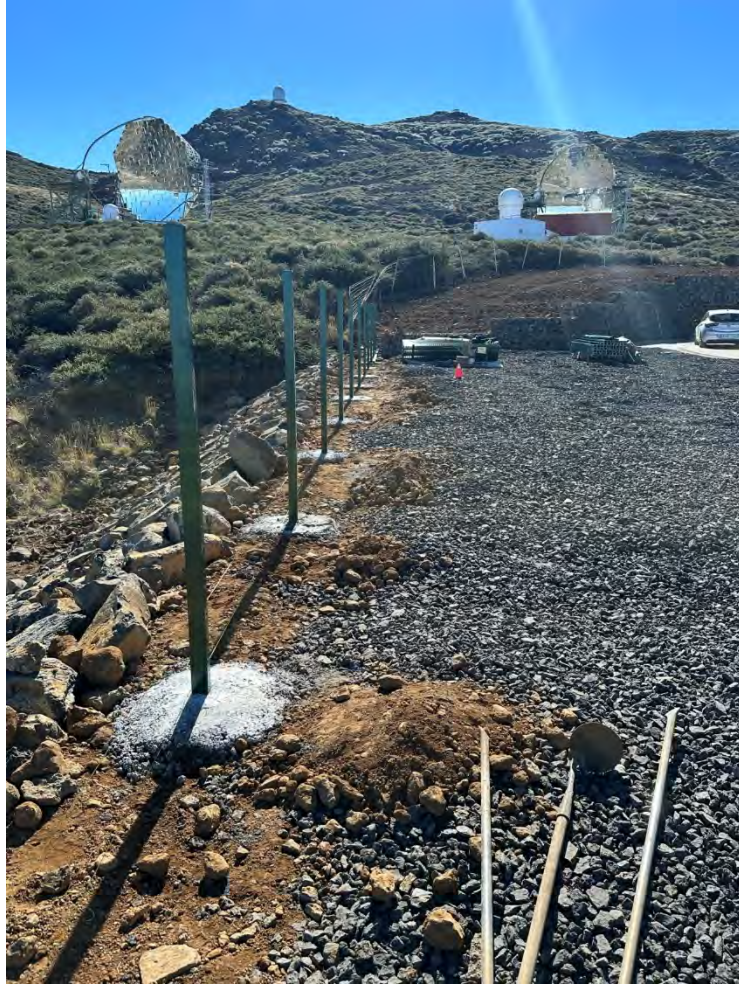
Colocación vallando LST4
