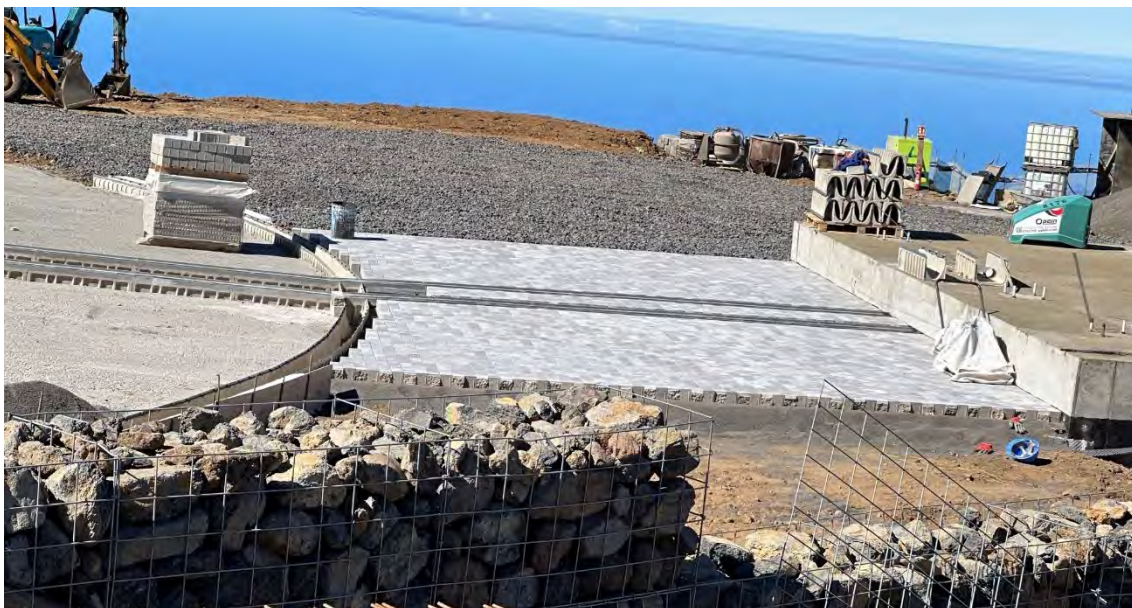
Plataforma LST2, comienzo de la colocación del adoquinado
