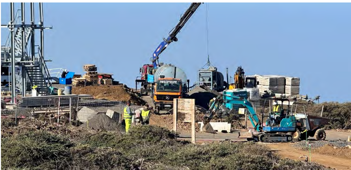
Vista desde el LST4, del desmonte y retirada de la planta de hormigón.
