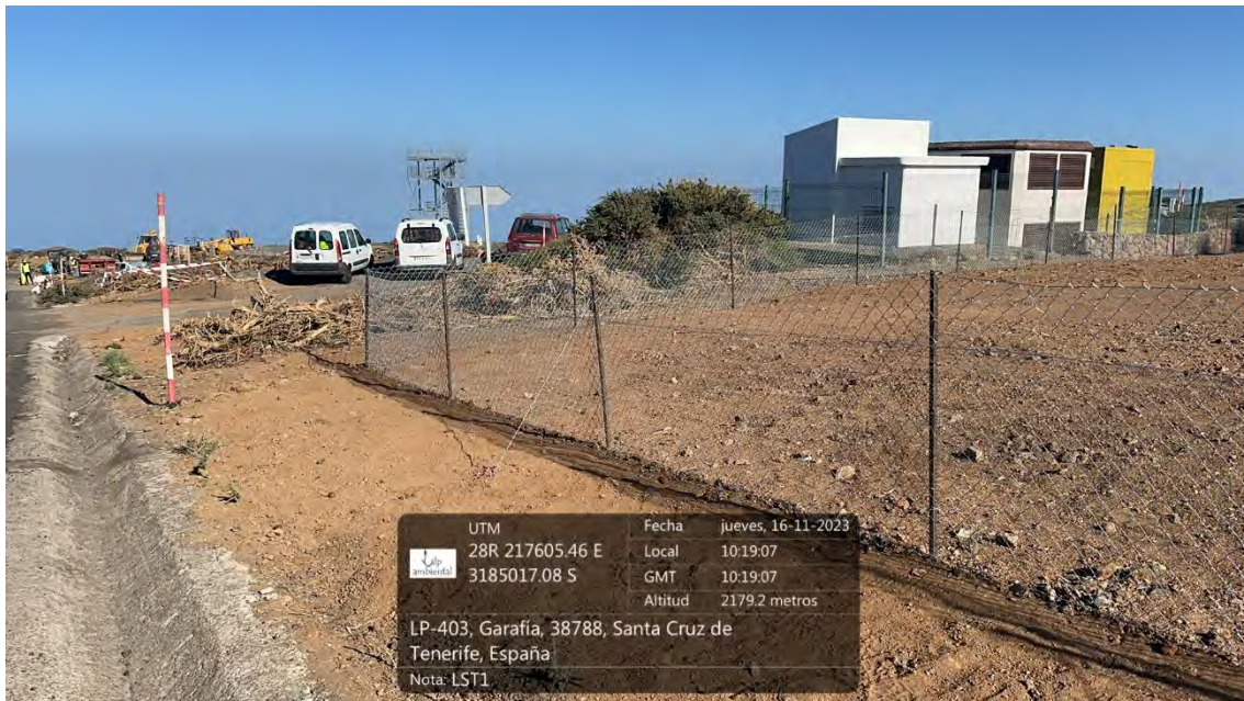
Finalización de soterramiento malla en la parcela de desmonte del LST1.
