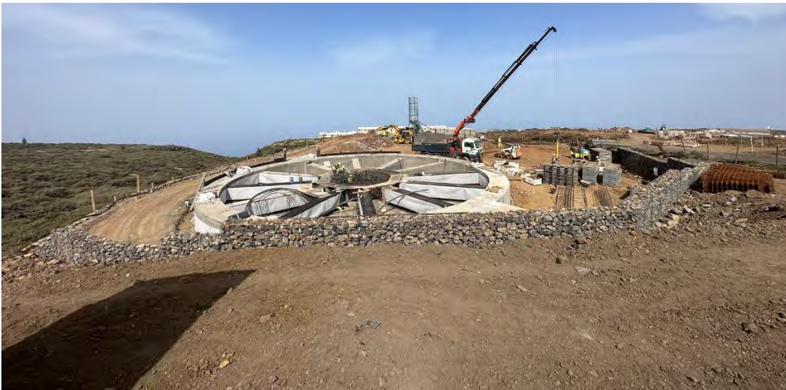
Vista de la plataforma del LST2 hacia el corredor ecológico.
