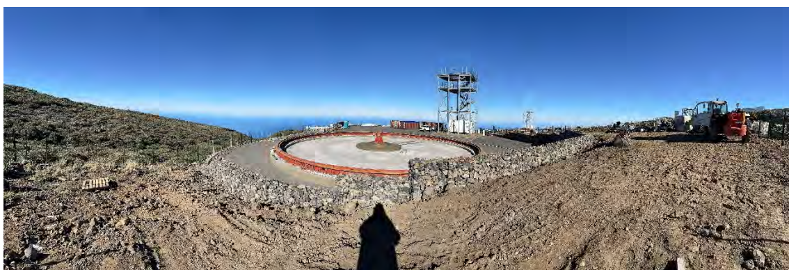
Vista plataforma LST2
