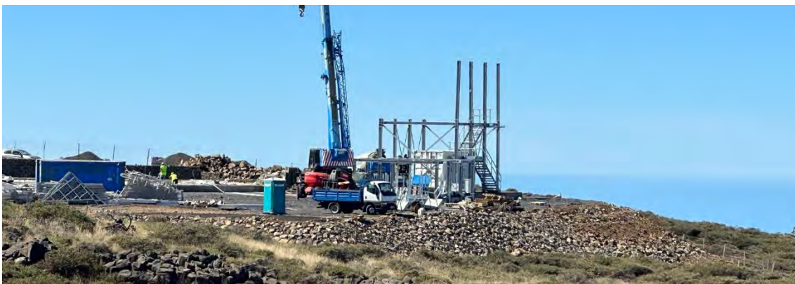
Vista plataforma auxiliar LST3
