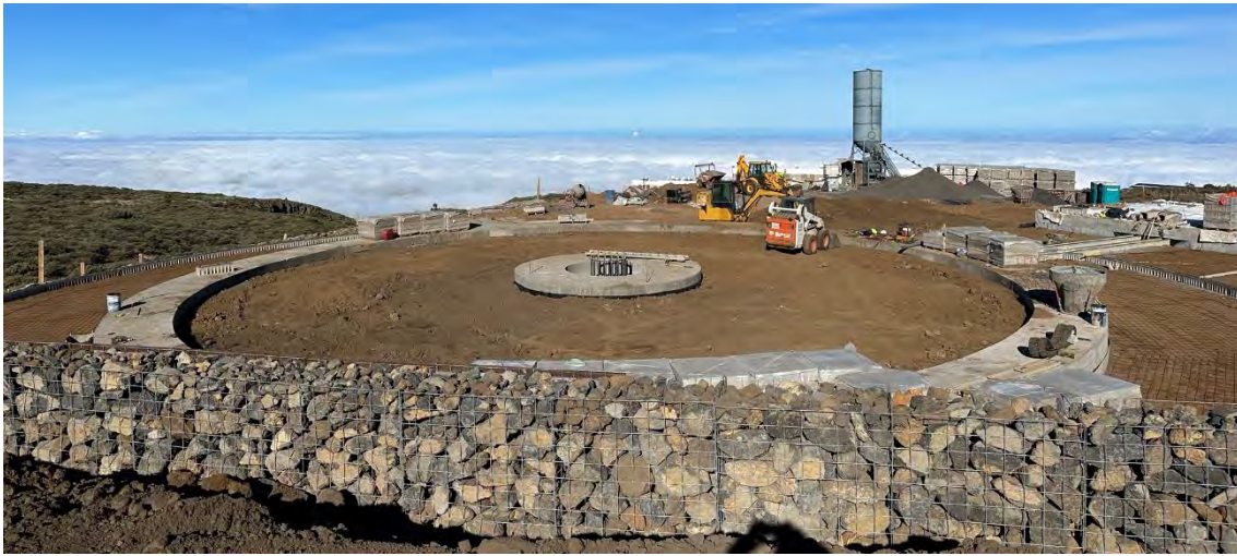
Vista del LST2 sobre la parte superior
