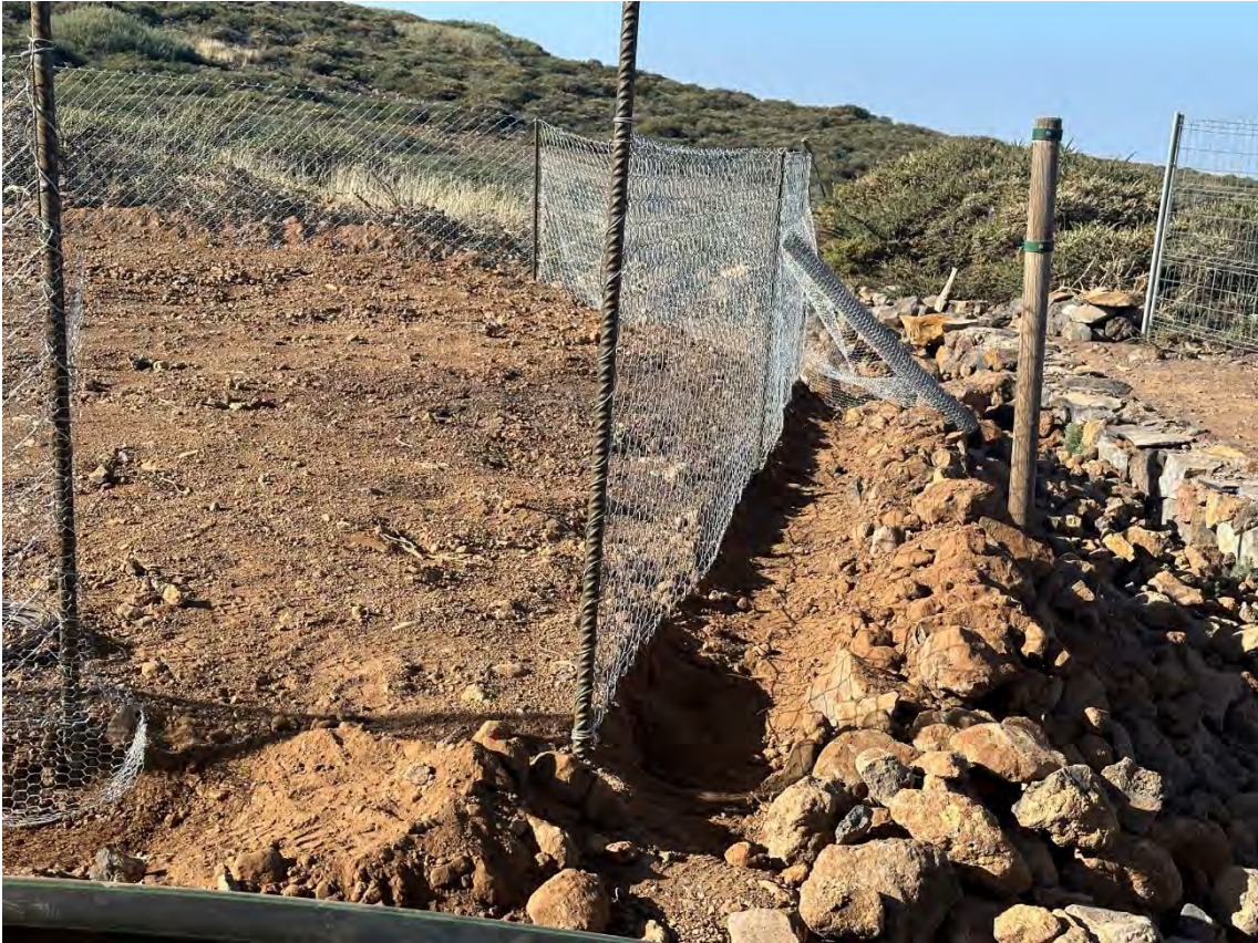
Soterramiento nueva malla en la parcela más próxima al corredor ecológico.
