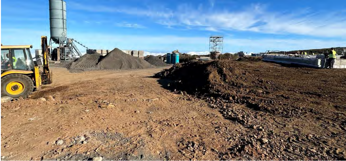
Relleno y nivelado plataforma alrededor del LST2
