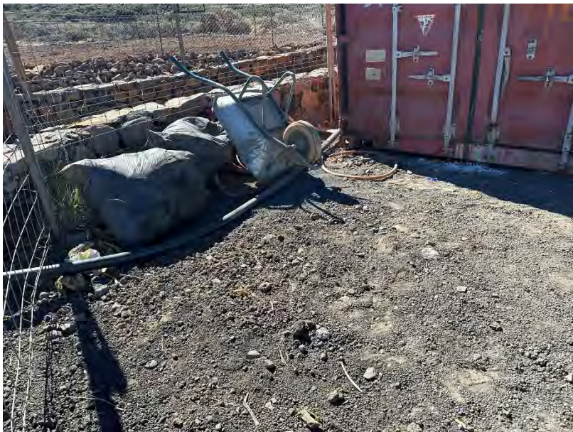
Zona de descanso del personal de la obra
