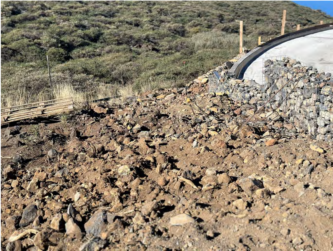
Plataforma desmonte helipuerto LST2
