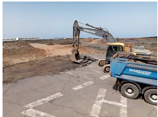
Retirada de asfalto de la zona del LST2
