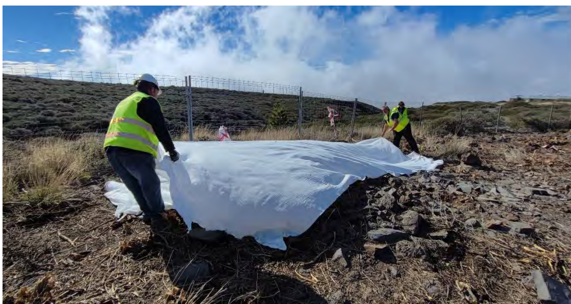
Colocación del geotextil.
