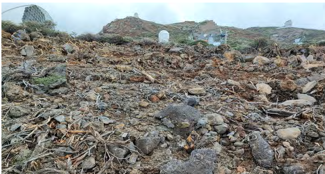
Zona de trabajo después del desbroce.
