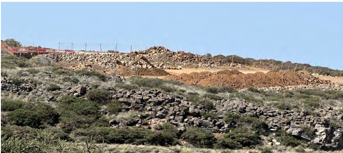
Vista LST3, donde se aprecian la colocación de tierras para su explanado y conformación de la plataforma auxiliar.
