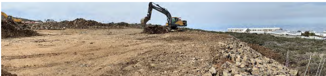
Plataforma auxiliar LST3 y escollera recubriéndose de los codesos
