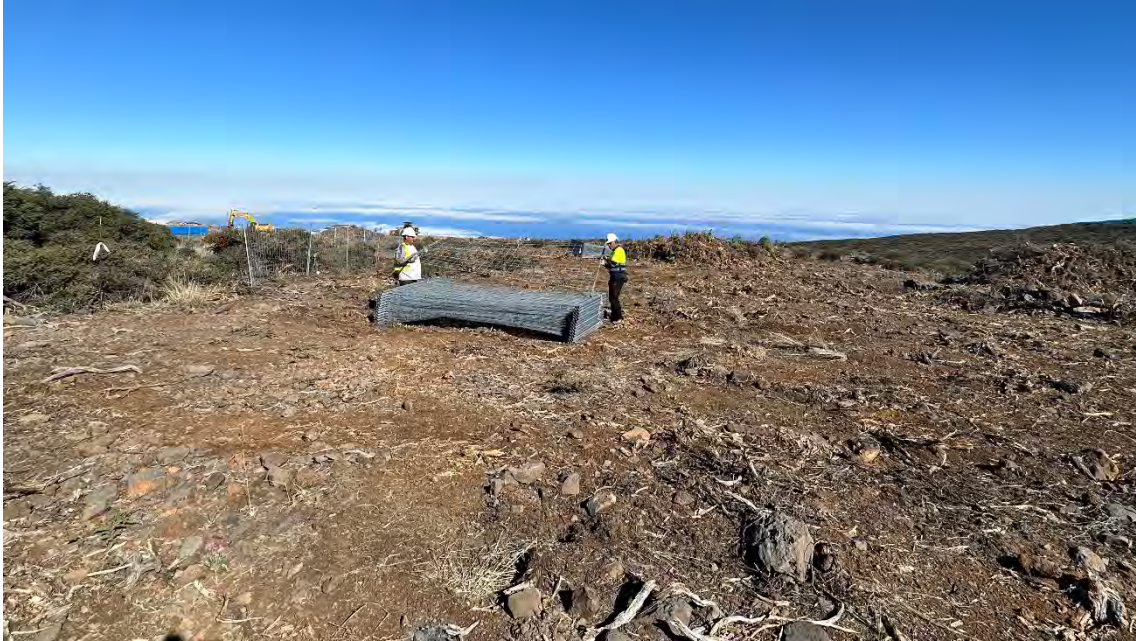
Colocación de vallas en zona LST4
