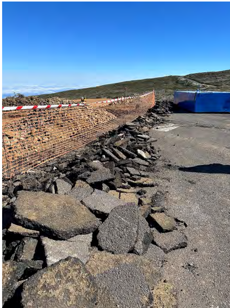
Desmante helipuerto próximo LST3
