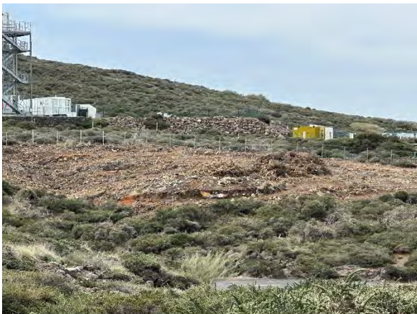
Acúmulo de codesos desbrozados en la zona del LST4
