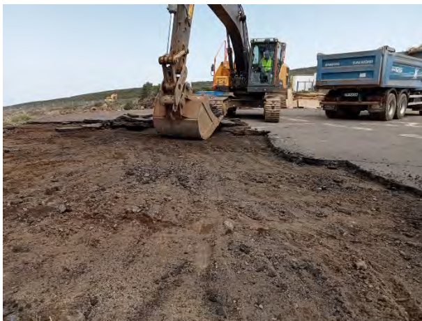
Retirada de asfalto de la zona del LST2
