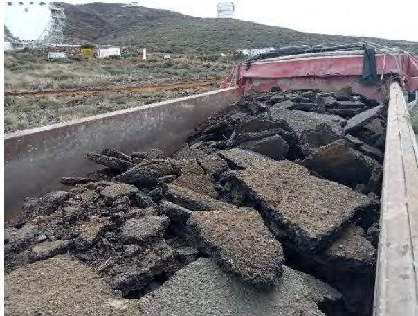
Retirada de asfalto de la zona del LST3
