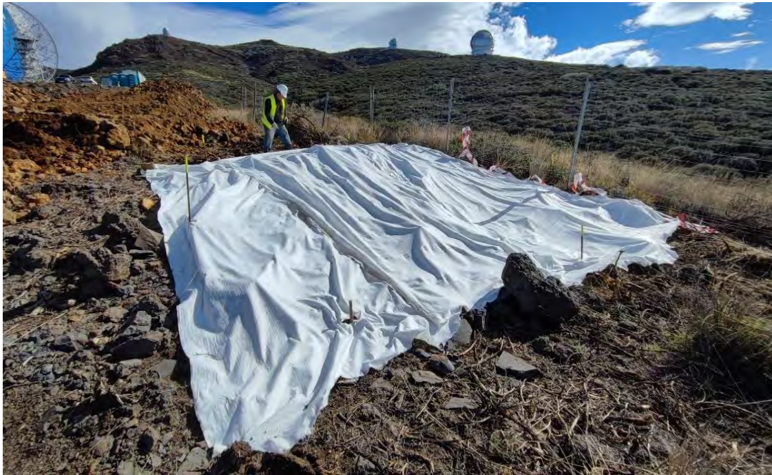
Colocación del geotextil.
