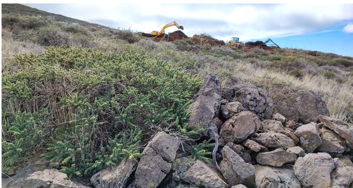
Vista desde el amontonamiento de piedra hacia la zona de desmonte para el futuro LST-3
