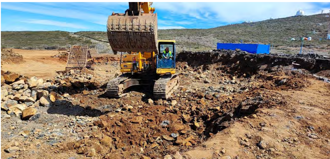
Desmontes del terreno para la construcción del LST-2 y LST-3.
