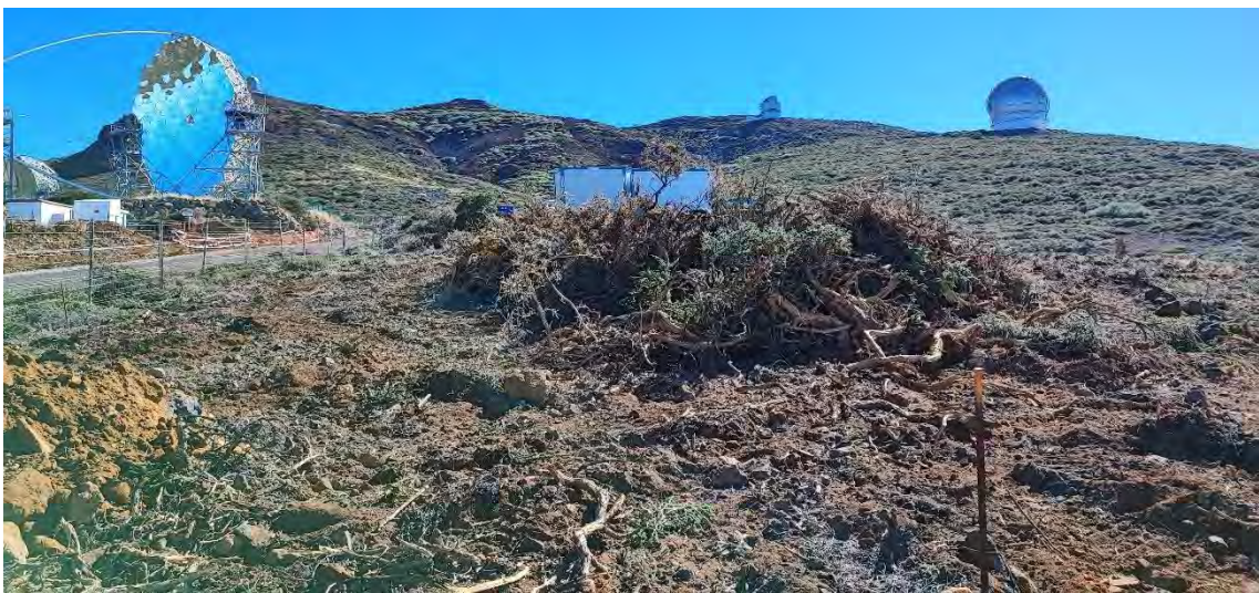
Imágenes de desbroce de la zona de trabajo.
