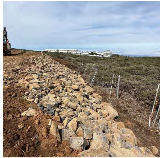
Colocación de parte de los codesos en la escollera del LST3
